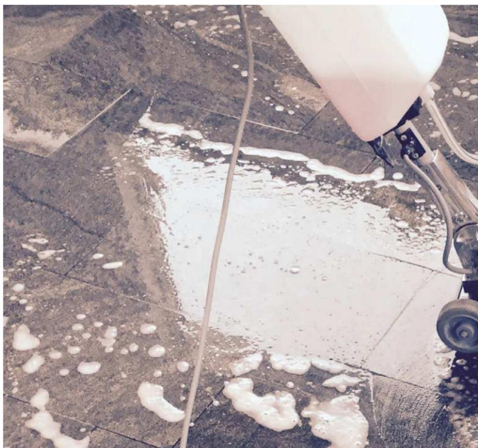
Einscheibenmaschine mit Nylonpad oder Nylonbürste gereinigt. Was die Maschine nicht erreicht, also z. B. Ecken, Ränder und Sockel, muss mit einem Handpad oder einer Handbürste nachbearbeitet werden. Die tiefer liegenden Zement- oder Silikonfugen werden zusätzlich mit einer speziellen Fugenbürste gereinigt. Anschliessend wird die Schmutzlösung mit einem Industriesauger aufgenommen und der Boden mit viel klarem Wasser 2–3 mal nachgewaschen.
